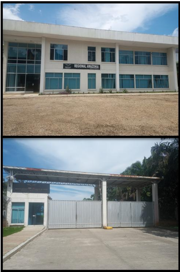
Fotografía 2 Edificio ALFM REGIONAL AMAZONIA
