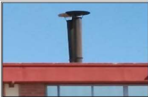
F.10 Techo bodega 37
