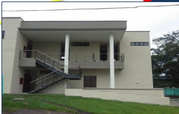
FACHADA PRINCIPAL - ZONA SERVICIOS
