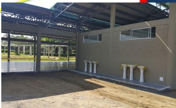
FACHADA PRINCIPAL - ZONA SERVICIOS
