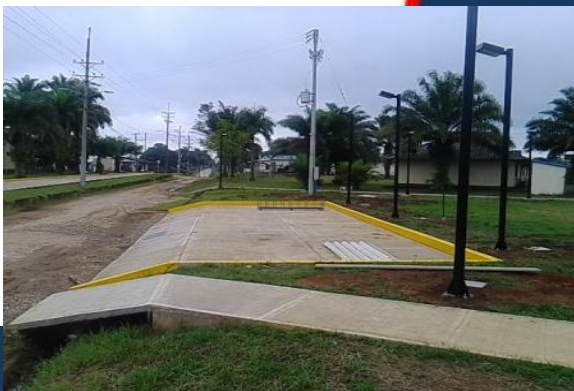
Parqueadero en concreto para alojamiento 2 y andén de acceso al alojamiento 2.
