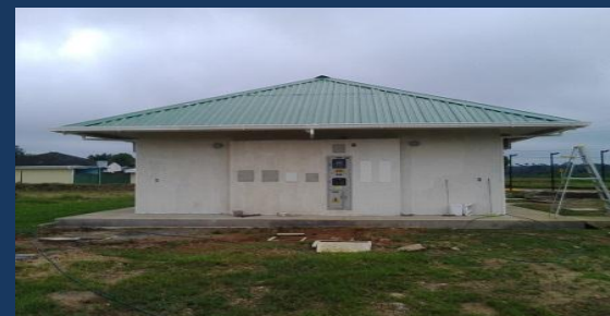
Fachada lateral izquierda y donde están instalados tablero eléctricos.
