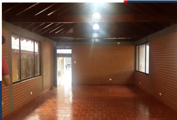
INTERIOR DE LAS OFICINAS
