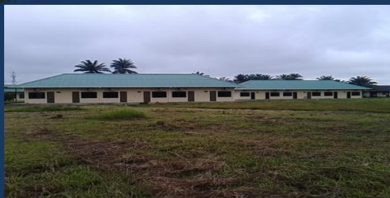
Vista de fachadas posteriores de alojamientos 1 y 2.
