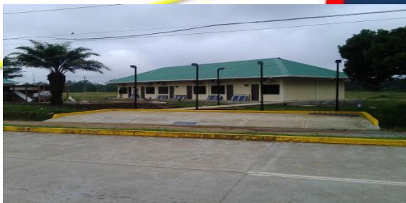
Fachadas principal y lateral derecha: Parqueadero, luminarias en andenes exteriores y parqueaderos.
