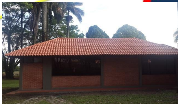
CUBIERTA EN TEJA DE BARRO TIPO S
