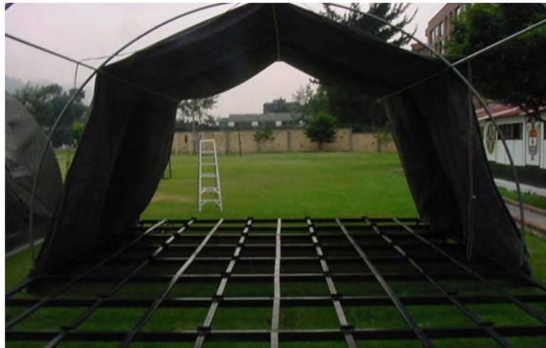
FIGURA No 5 VISTA ARMADO ESTRUCTURAL FRONTAL
