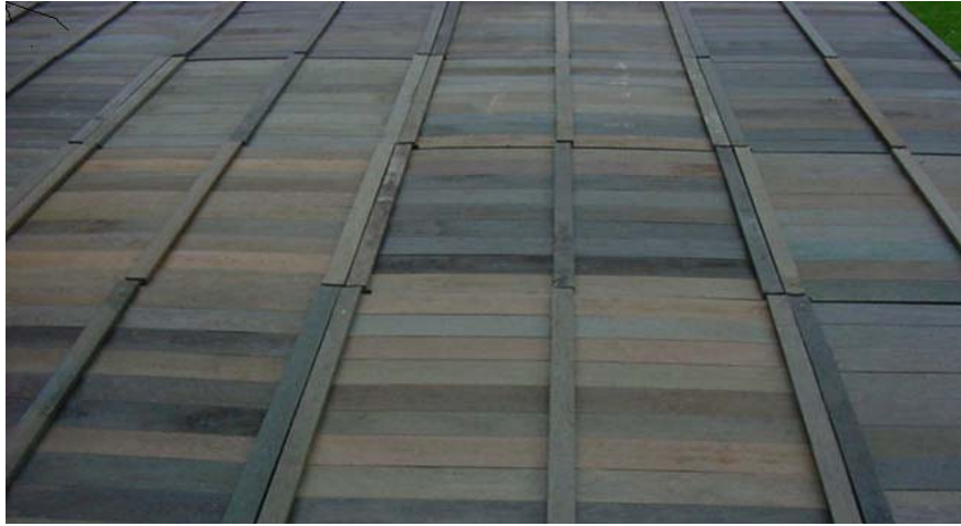
Estructura de piso – 30 x 50 mm en punto- 80 1 mts x 97 cm. Grosor 7 cm. Distancia hasta el suelo 25 cm
